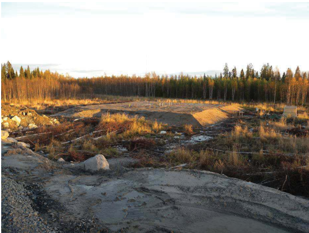
Figur 50. Översiktsvy på bank 2 vid färdigställande.
