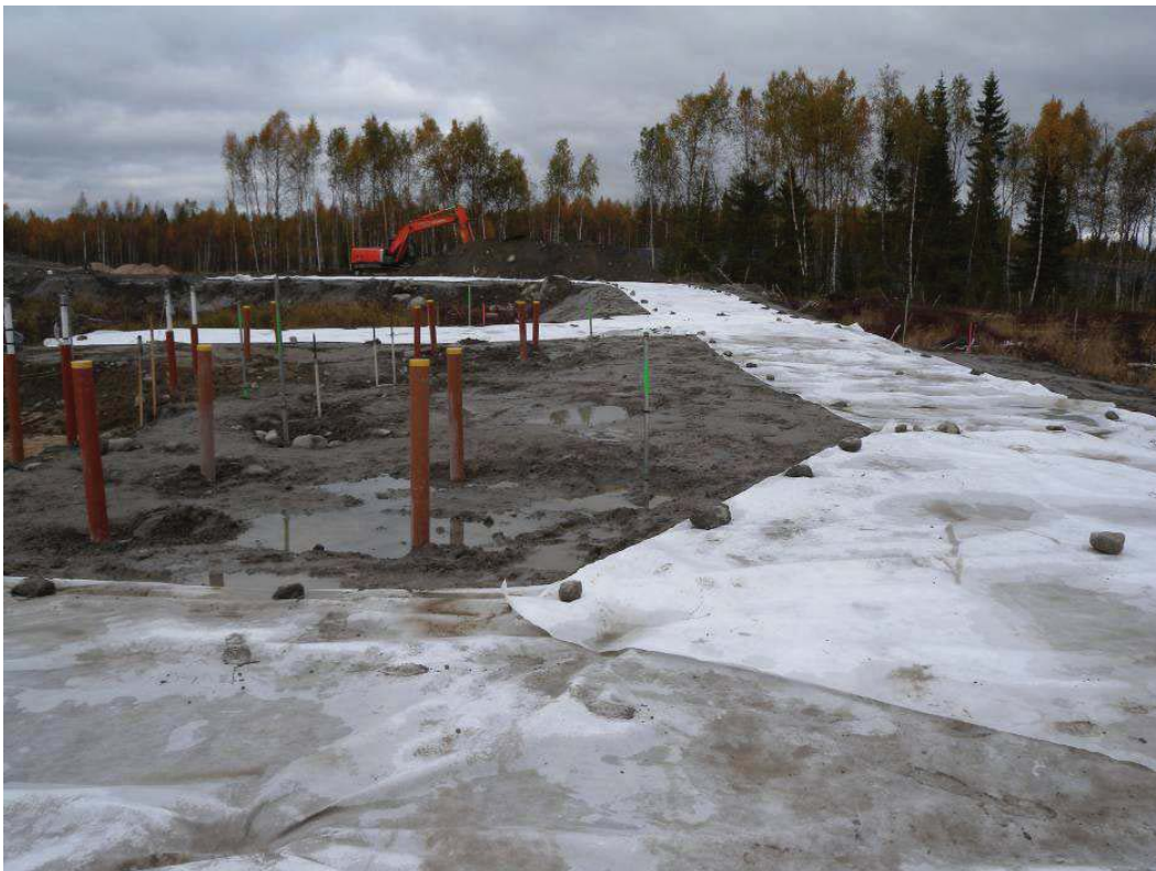
Figur 48. Första uppbyggnadspallen för bank 2 är nästan färdig, en 5 meter bred geotextil rullades ut och överfylldes med ett 4 – 5 dm tjockt lager sprängsten.
