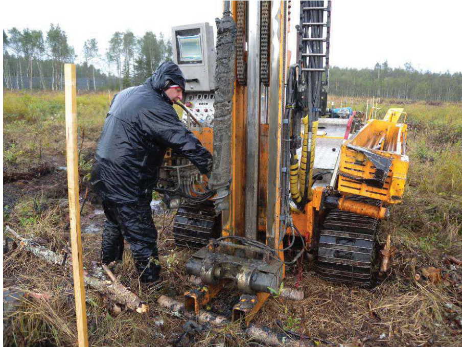
Figur 44. Förborrning med 100 mm jordskruv för att kunna installera foderrör till portrycksspetsar.
