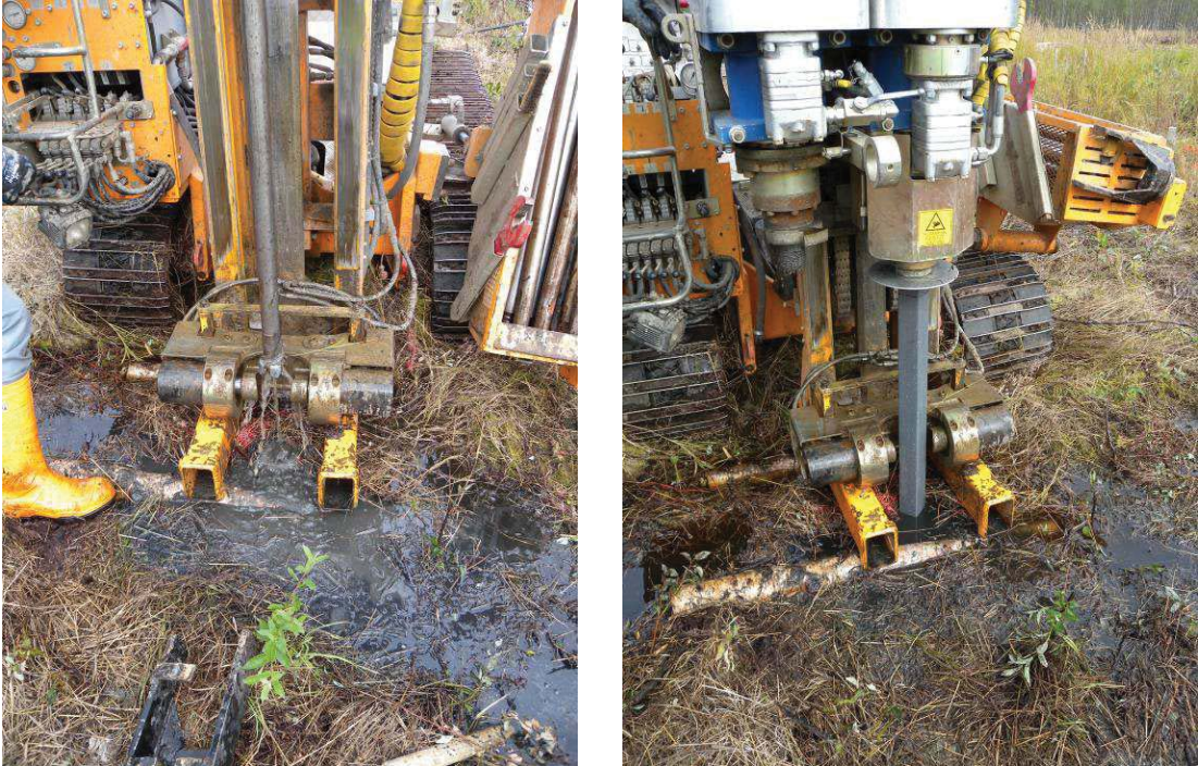
Figur 41. Till vänster förborrning för installation av inklinometerrör med jbsondering och vattenspolning (76 mm krona). Till höger visas nedpressningen av ett inklinometerrör.
