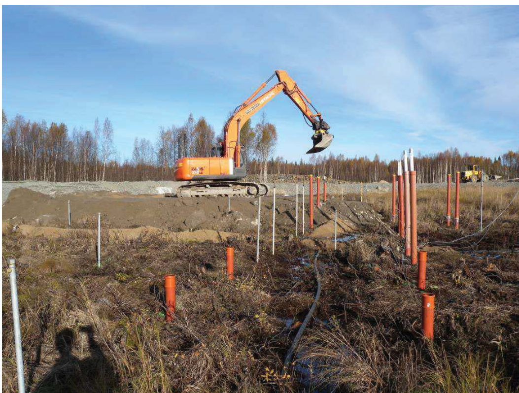
Figur 51. Första delen i uppbyggnaden av bank 1, sandsträngarna som syns centralt i bilden är skyddslagret som överlagrar horisontalslangarna.
