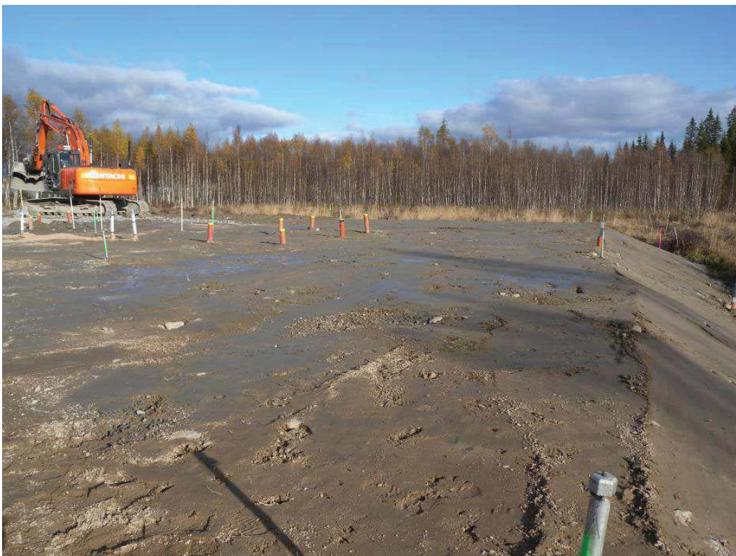
Figur 49. Bank 2 är färdig och slänterna justeras till lutning 1:2.
