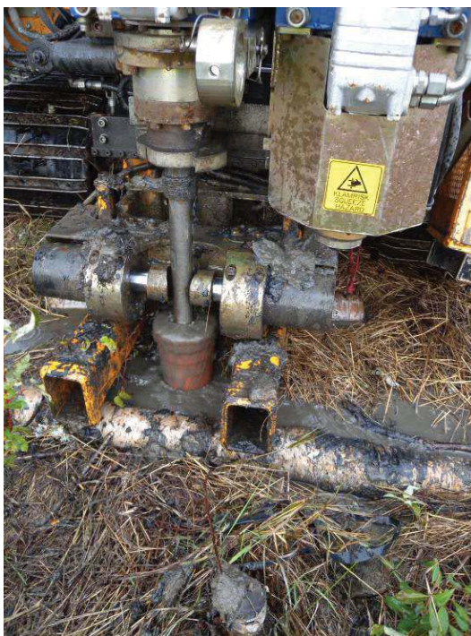
Figur 45. Installation av foderrör till portrycksspetsar inklusive portrycksspetsar och rör. Till vänster i figuren visas ett foderrör som blir urspolat med jbsonderingsutrustning. Till höger i figuren visas två färdiginstallerade portrycksrör.
