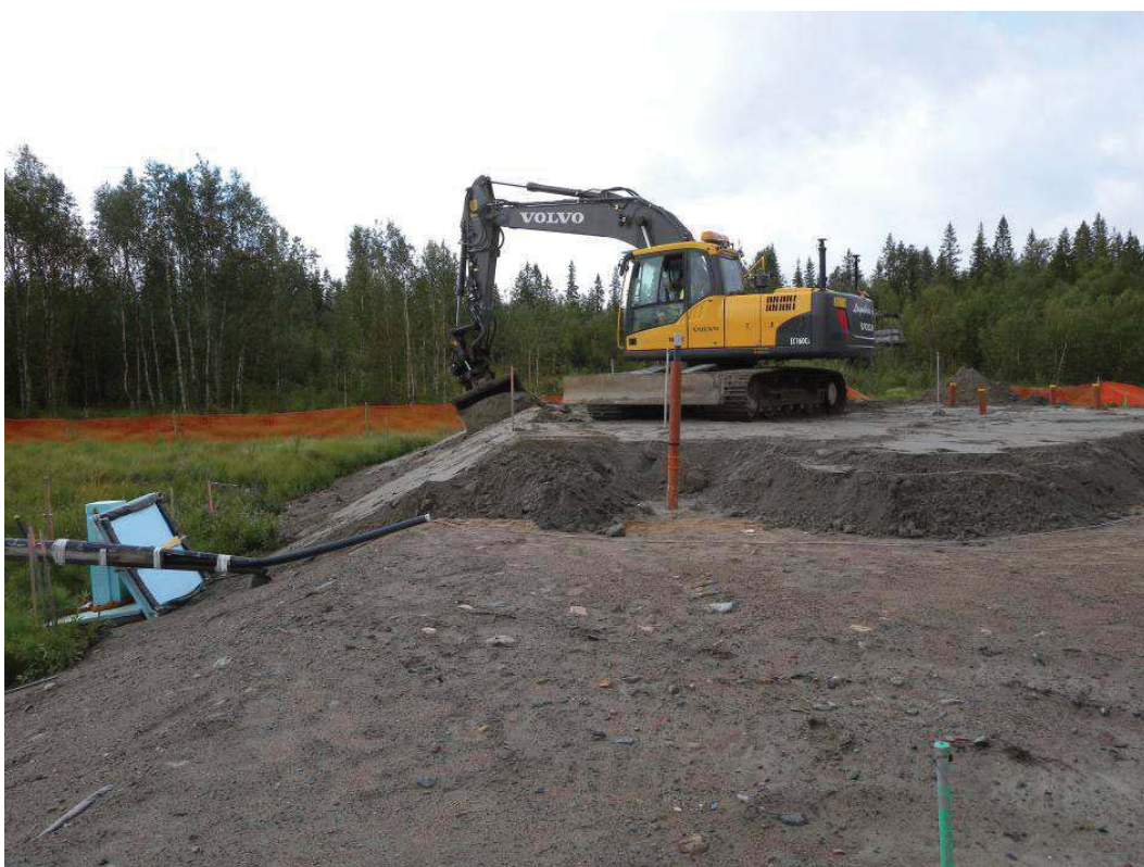
Figur 55. Etapp 2 för bank 1, ytterligare 0,5 m tjockt lager morän byggdes på den redan 1,5 m höga banken. Den totala bankhöjden är nu 2,0 m.
