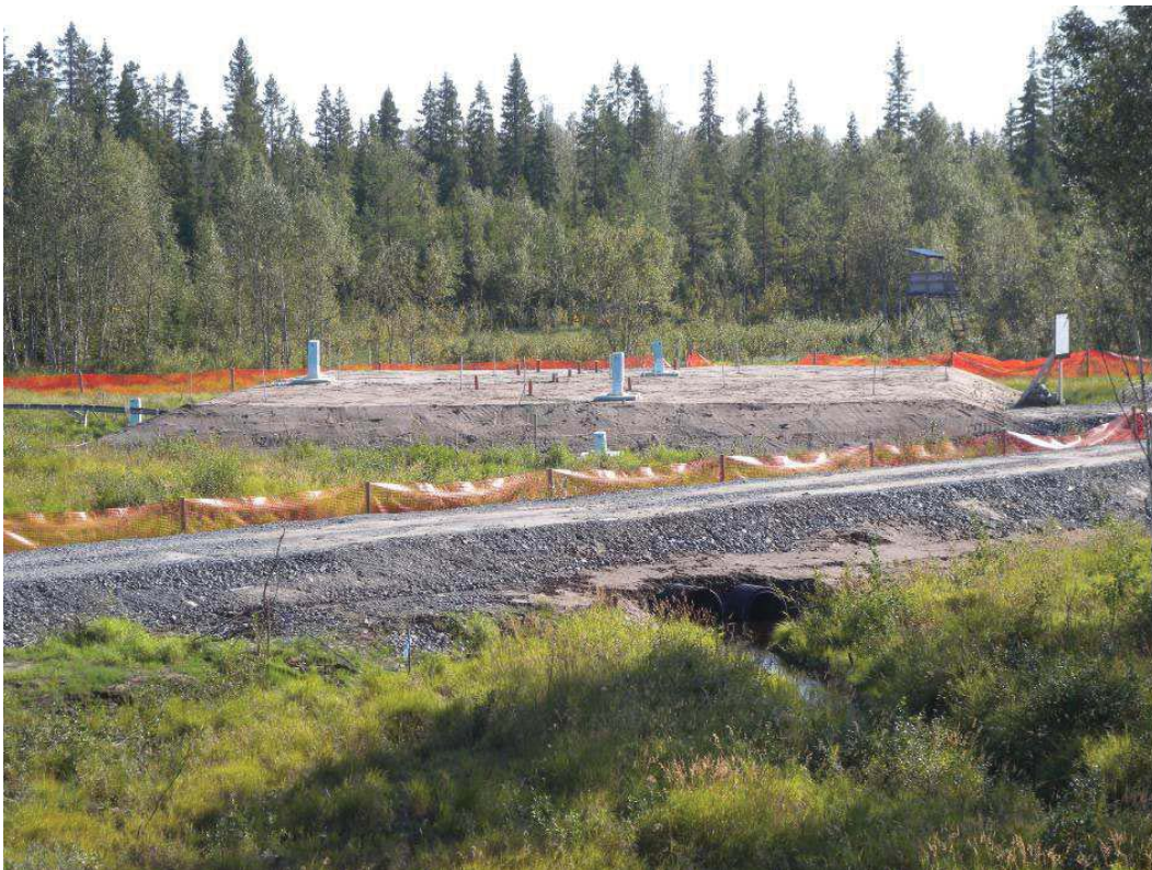
Figur 56. Översiktsbild över bank 1 efter färdigställande av etapp 2.
