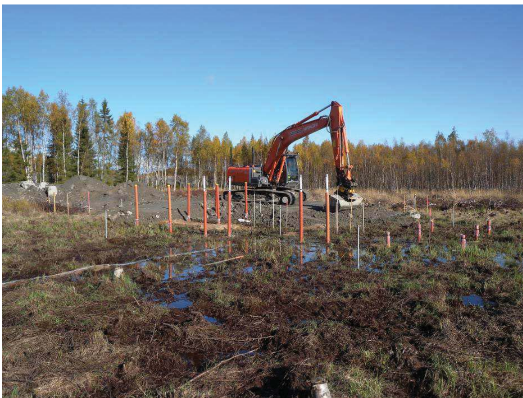
Figur 47. Byggnation av transportväg ut till nordöstra hörnet på bank 2 samt påbörjad 1 m pall.
