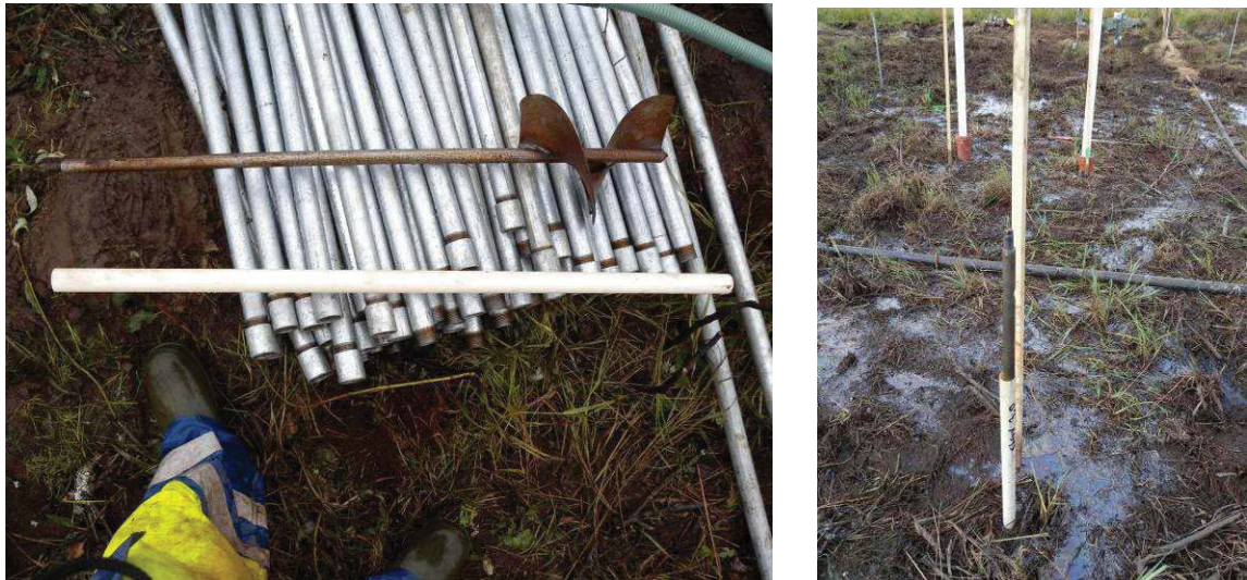
Figur 39. Till vänster visas en bild på nedersta delen av skruvpegeln samt ett foderrör. Till höger visas en färdig installerad skruvpegel (3m djup i bank 2).
