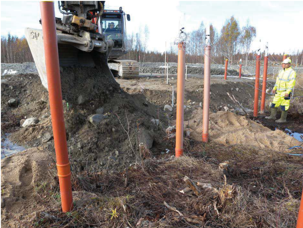
Figur 52. Försiktig uppfyllnad utfördes omkring alla mätinstrument för att skydda dem och för att se till att de behåller sin vertikala installation.
