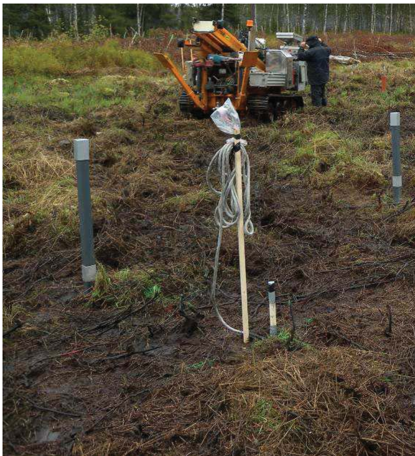
Figur 20. Installerad temperaturstav med upphängd anslutningskabel (före installation i mätskåpet).
