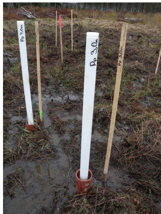
Figur 45. Installation av foderrör till portrycksspetsar inklusive portrycksspetsar och rör. Till vänster i figuren visas ett foderrör som blir urspolat med jbsonderingsutrustning. Till höger i figuren visas två färdiginstallerade portrycksrör.
