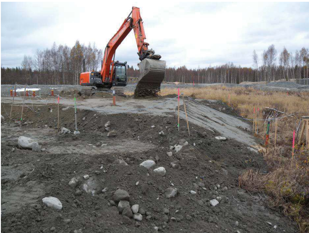
Figur 53. Uppbyggnad av pall 2 (0,5 m) för etapp 1 vid bank 1, nordöstra hörnet på bank 1.
