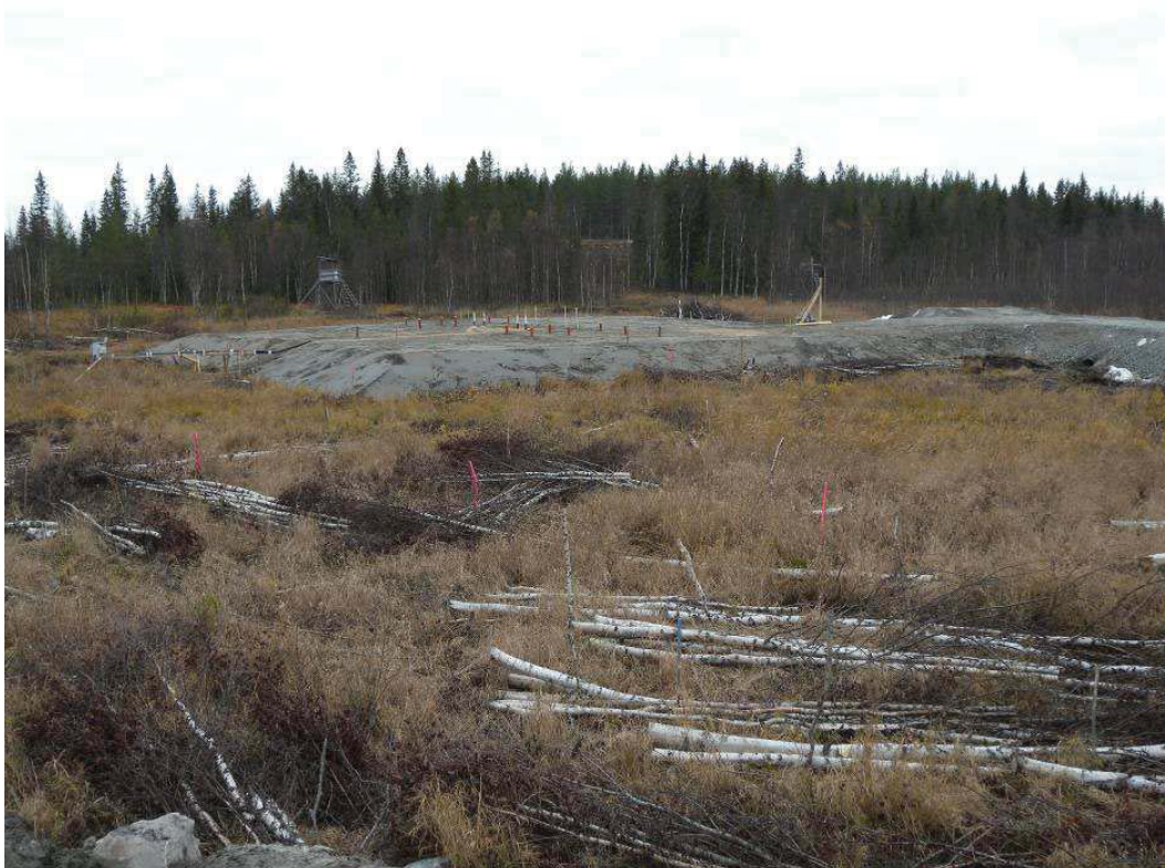
Figur 54. Översiktsbild över bank 1 efter färdigställande av etapp 1.
