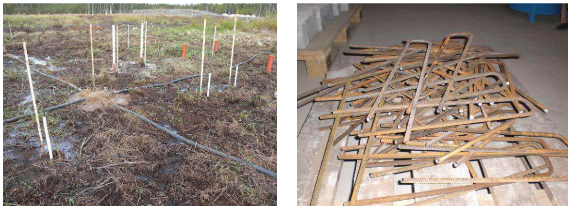
Figur 34. Bild på centrum av bank 2, där de två horisontalslangarna möts. Till höger visas armeringsbyglarna som användes för att nagla fast slangen i torven.
