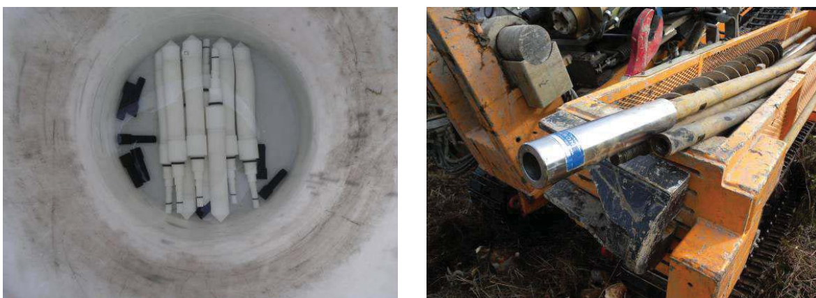
Figur 46. Till vänster i figuren visas de installerade porttrycksspetsarna förvarade i ett vattenbad för att behålla vattenmättnaden. Till höger i figuren visas den adapter som användes för att installera spetsarna.
