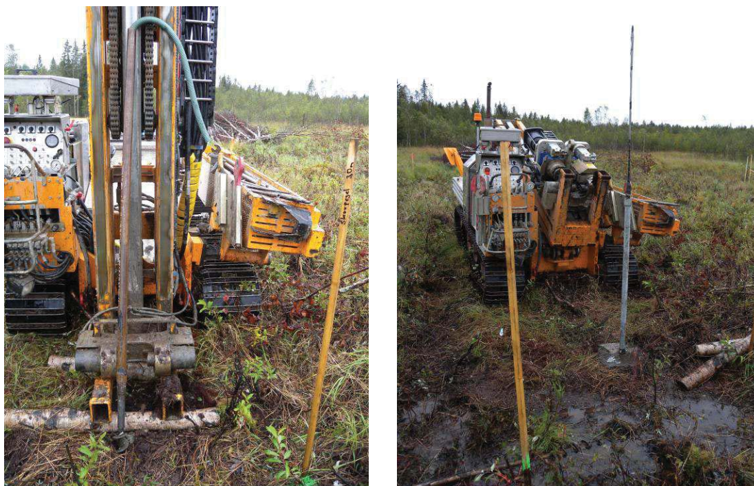
Figur 38. Installation av bälgslang, till vänster i figuren syns bälgslangen inklusive bottenkruv omgivna av sättningsrören. Till höger i figuren visas en färdiginstallerad bälgslang med markplatta och foderrör samt uppspänd med ett innersystem av stålstänger.
